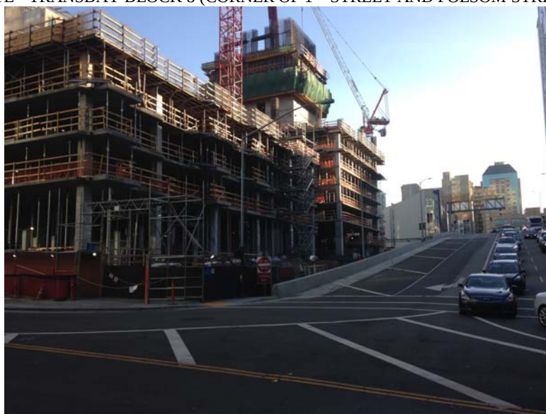
SITE – ABUTS INTERSTATE 80 OFF-RAMPS
