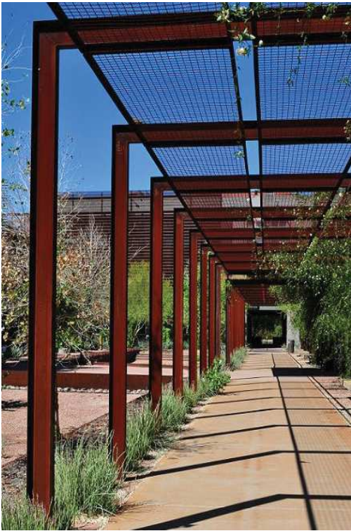
CORTEN I BEAMS
